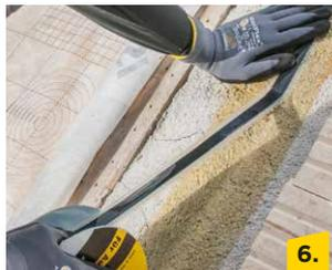
6. Vario® ProTape Xtren auf den mit Vario® MultiPrime vorbereiteten Untergrund auftragen.
