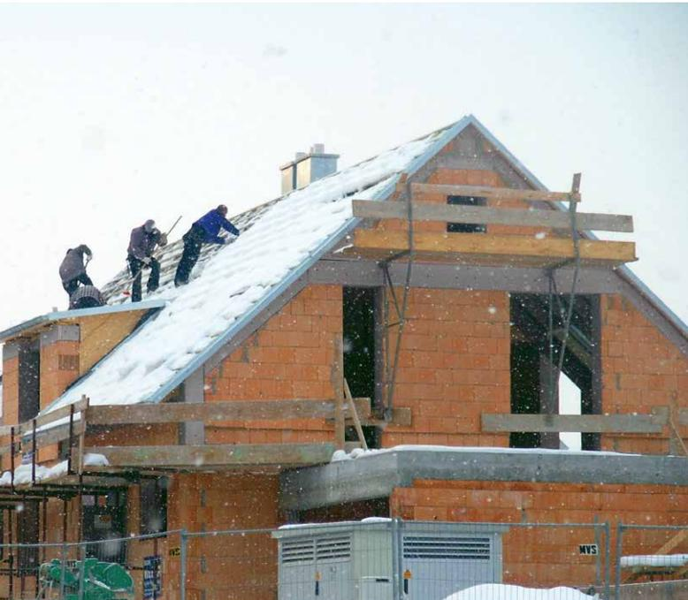
Die Vario® Klimamembranen können auch in der winterlichen Bauphase eingesetzt werden. Allerdings können im Rohbau bei extrem hoher Luftfeuchtebelastung bereits kleinste Leckagen in der luftdichten Ebene zu schwerwiegenden Bauschäden führen. Deshalb gilt: Nach der Wärmedämmung muss unverzüglich die leckagefreie luftdichte Ebene installiert und an angrenzende Bauteile angeschlossen werden, bevor ausdiffundierende Feuchtigkeit aus Putz oder Estrich in die Konstruktion gelangt.
