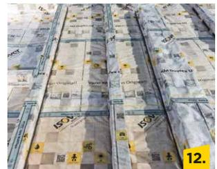
12. Vario® KM Duplex UV ist nun vollständig verlegt und fachgemäß luftdicht angeschlossen.
