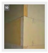
An den Ecken werden die Platten ebenfalls im Verband verlegt, wobei der Plattenrand um die Plattendicke zuzüglich der Dicke des Klebemörtels über die Gebäudeecke herausragen muss (Abb. 10).
