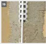
mörtel **weber.mix 125** unter Berücksichtigung der Dicke des ausgesuchten Putzsystems entweder direkt auf die Panzereckwinkel oder auf die Armierungsschicht gesetzt **(Abb. 19).**
