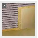
Beim Holzbau sind die Verarbeitungsrichtlinien des Dämmplattenherstellers (Zulassung) zu berücksichtigen. Alternativ kann der Klebemörtel auch vollflächig aufgespritzt und mit Zahnglätter (10 x 10 mm) aufgekämmt werden. Die Dämmplatten werden sofort danach (max. 10 Minuten nach dem Anspritzen des Klebemörtels, je nach Witterung und Untergrund auch weniger) in
