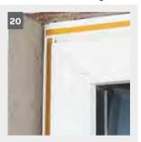
Der Anschluss zwischen Fensterrahmen und Putz wird durch das Anbringen einer Gewebeanputzleiste mit integriertem Dichtband, z.B. w 29 oder w 36 hergestellt (Abb. 20).
