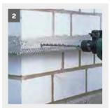
a) Ein zur Plattenstärke passendes Sockelprofil in Trogform wird mit Profil-Dübeln weber.therm 342 (3 Stück pro laufender Meter) angebracht (Abb. 2) und mit Sockelverbindern montiert. Zusätzlich kann das Profil auf ganzer Länge in Profilansetzund Installationsmörtel weber.mix 125 gelegt werden, was insbesondere bei unebenen Untergründen notwendig ist, um einen dichten, unteren
