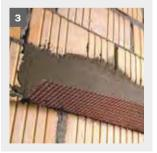
Hierzu wird ein Panzereckwinkel weber.therm 312 mit Klebeund Armierungsmörtel weber.therm 300 auf der Wand befestigt, in den später die Dämmplatten geklebt werden (Abb.3).
